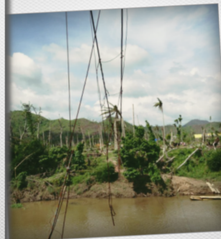
橋が壊れ、分断された集落
