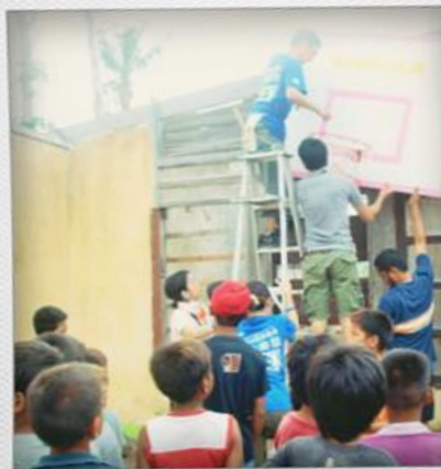
バスケットゴールの設置
